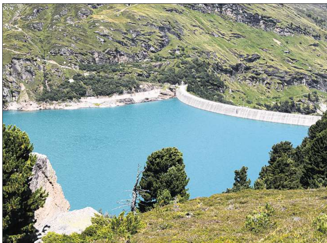
La regenza grischuna sefatschenta en cuort culla damonda da concessiun dalla Ovra electrica Zervreila. Quella vul menar l'aua dalla Lumnezia sura al pei dil lag da fermada Zevreila.
