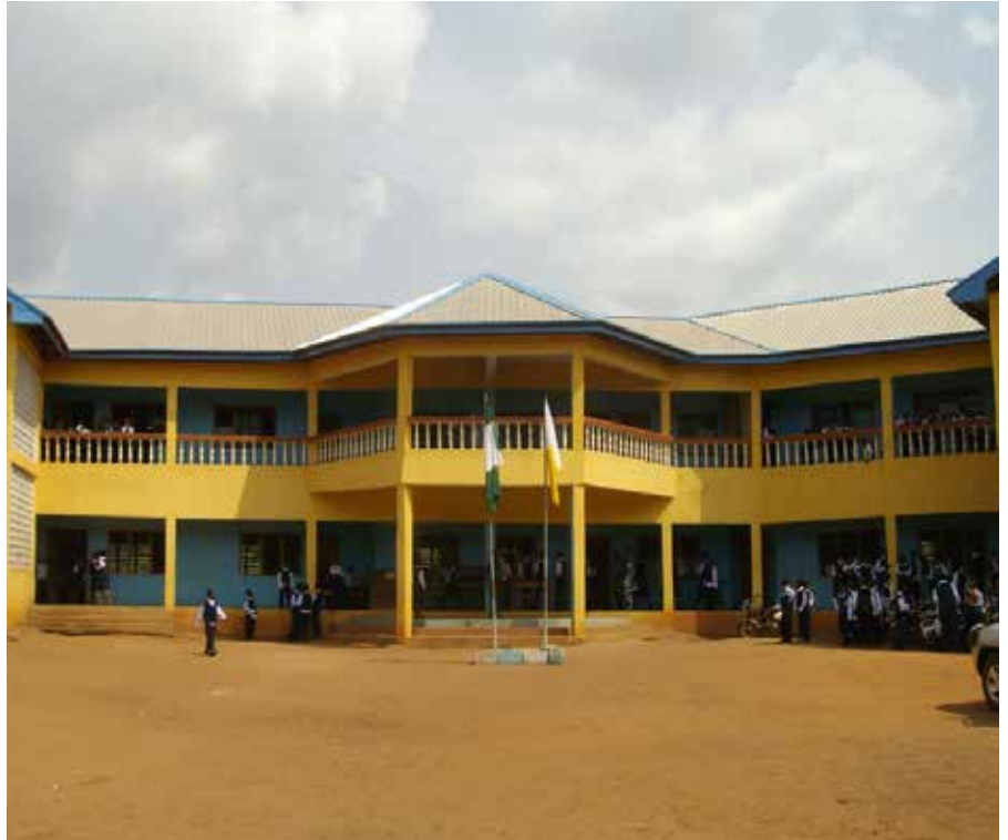
Bau einer Sekundarschule in Ahiara, Nigeria
